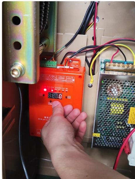
第五步 遥控器直接“开、关、停”听到“嘀”声按“确定”回到“F-38”
